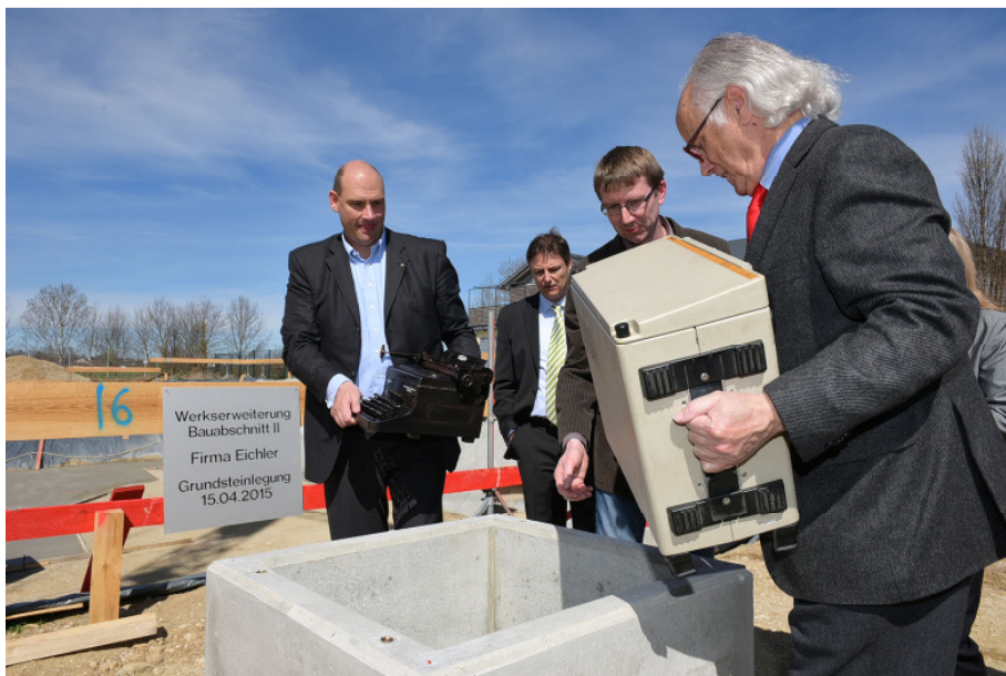
In den Grundstein des neuen Bauabschnitts wurden für das Unternehmen wichtige Erinnerungsstücke eingebracht.
